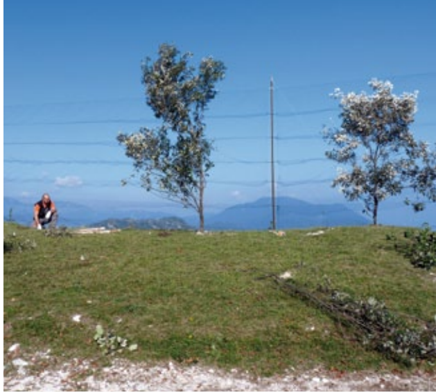
Lavori per la mascheratura delle reti realizzati dagli operai forestali di ERSAF.
