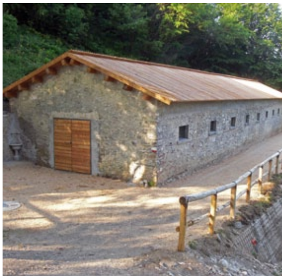
Stallone ristrutturato per finalità didattiche.
